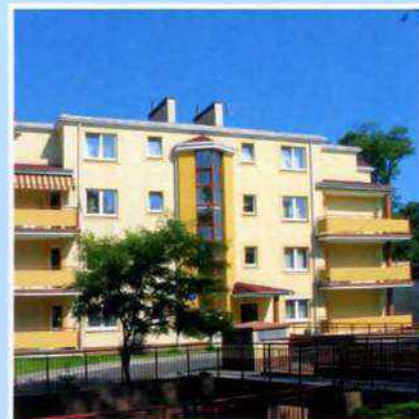
Zespół sześciu budynków mieszkalnych przy ul. Żegańskiej 28, 28A, 30, 30A, 32, 32A
